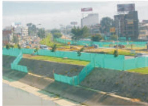
Cuando las cunetas y demás obras de drenaje de una construcción confluyan directamente a un cauce natural, construya sedimentadores que garanticen la calidad de las aguas vertidas en corrientes naturales.
